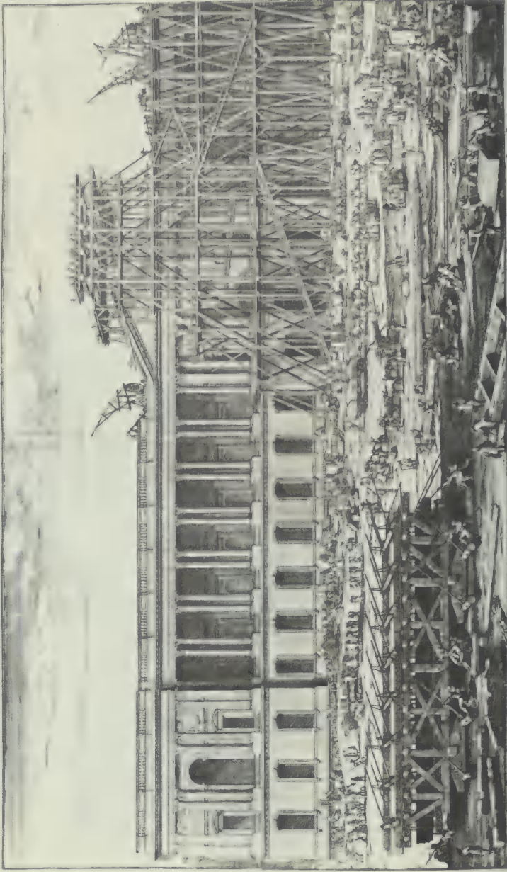
Les Machines qui ont servi à élever la Voûte grande pierre qui ouvrent le front de la principale entrée du Louvre
